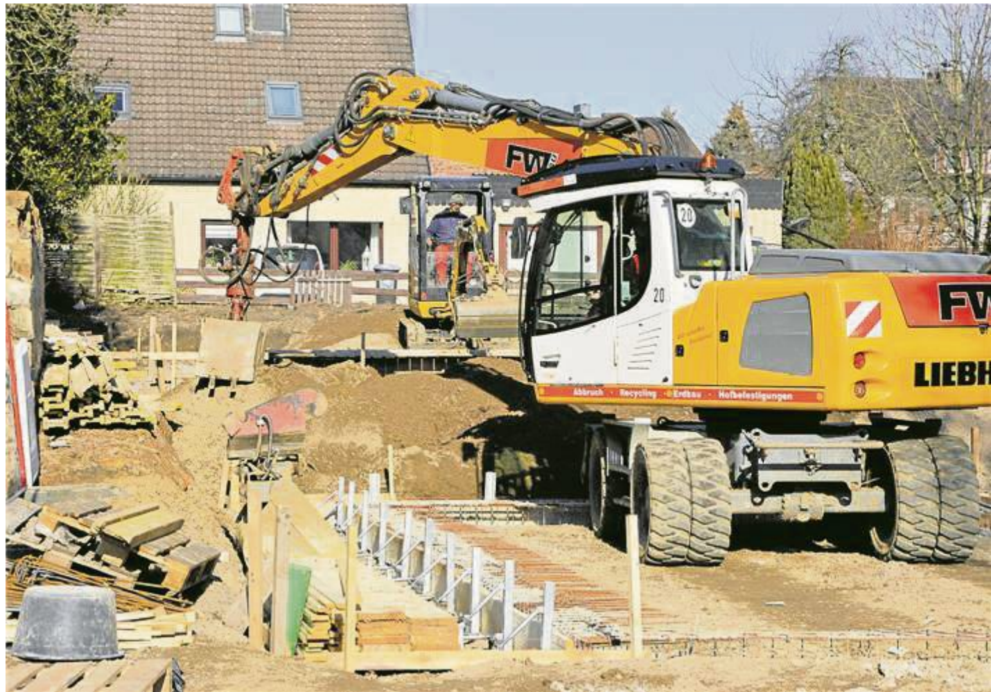
Derzeit laufen an der Heidstraße die Arbeiten am Fundament.
